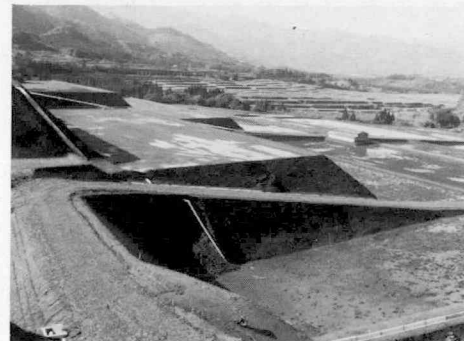
完成間もない頃の高田山地区（新田）
