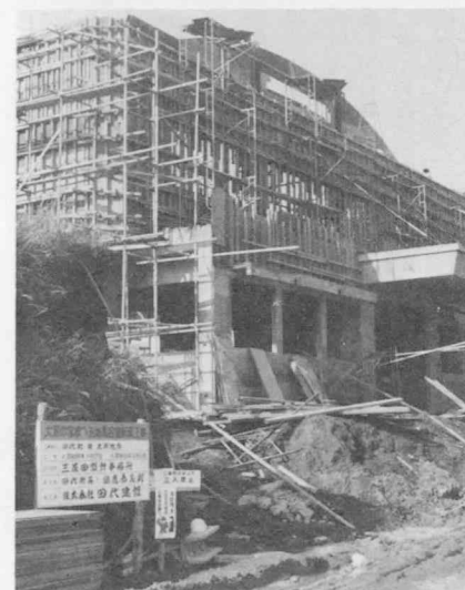
大原中体育館着工(三月に完成の予定)
