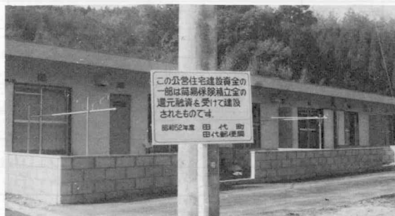
町営住宅完成
