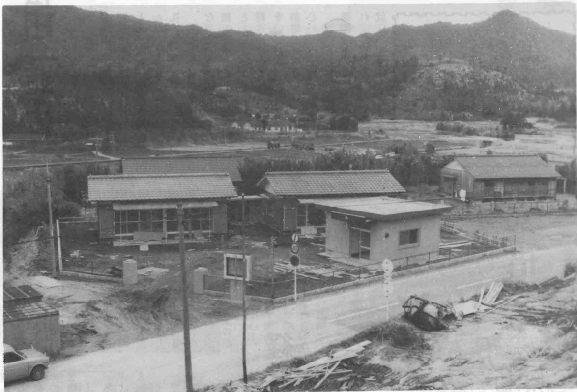
(完成間近い駐在所)
