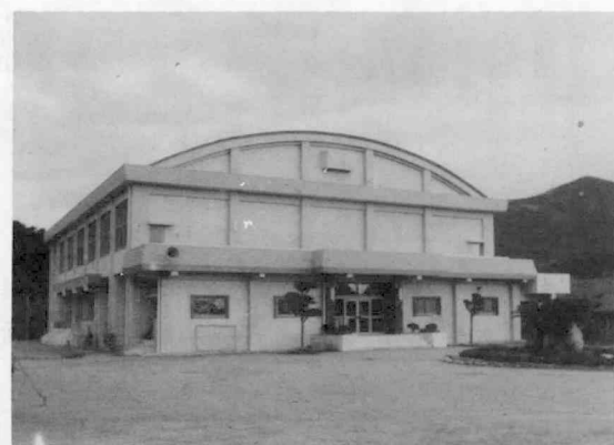
(完成した高校体育館)
