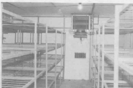
工場内部設備
