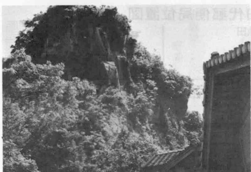
平石の危険箇所
