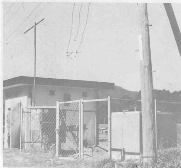
(中村前水源地) 【簡易水道水源工事完成】
