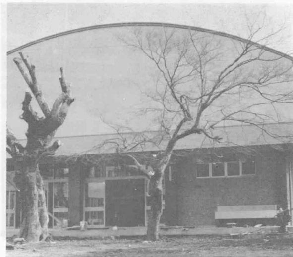
【田代小学校屋内運動場完成】
