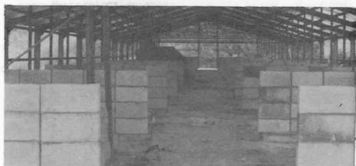
(完成した豚舎)
