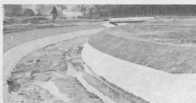
麓川河川改修工事終点竹下橋より下流をみる 49.4
