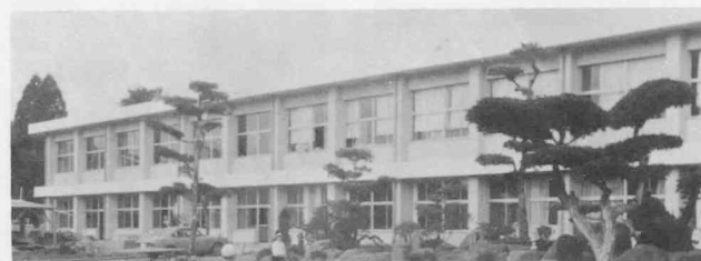
(写真は完成した田代小学校)
