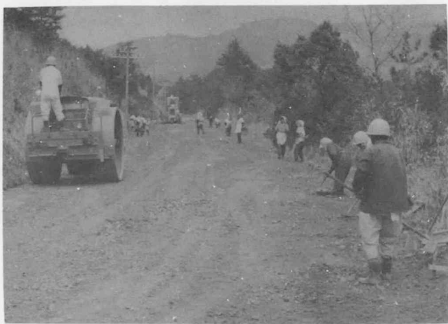
花瀬～大原間町道舗装完了 (4.800 m)
