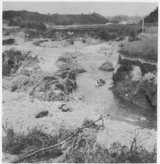
麓川上流も決壊（岩崎部落前）
