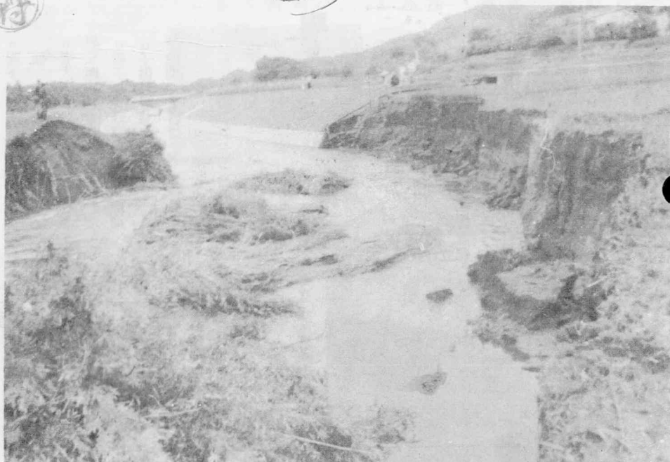
(写真は6月14日～16日の大雨による水害状況高校前附近)
