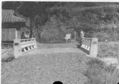
長谷橋（鉄筋延長7 m）
