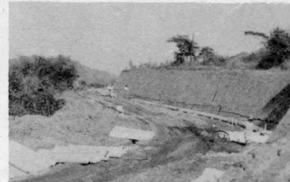
(写真は太原前附近の工事現場)
