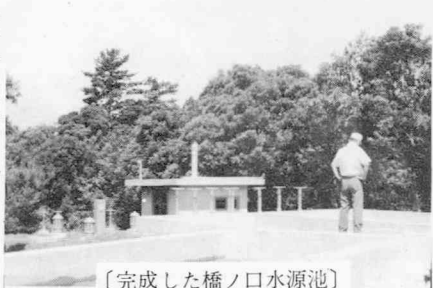
〔完成した橋ノ口水源池〕
