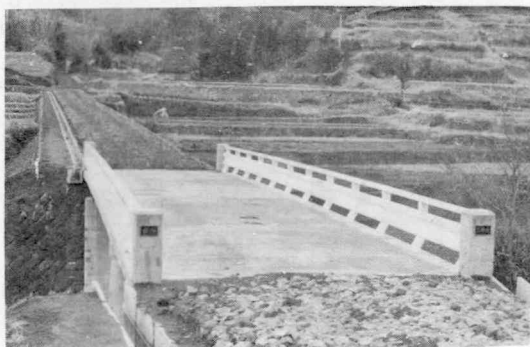
写真は完成した大原立神橋
