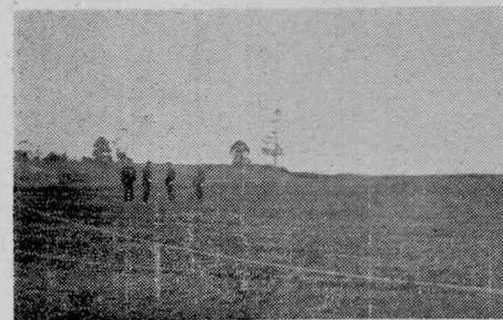
三、田代中学校の移転敷地の整地完了し建築始まる。
