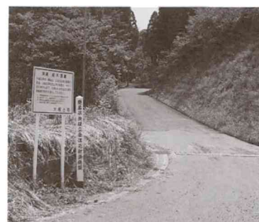
姫木場線の舗装
