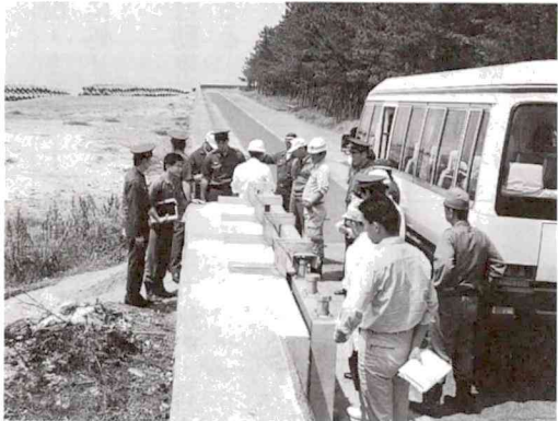
3年度に整備された防潮扉
