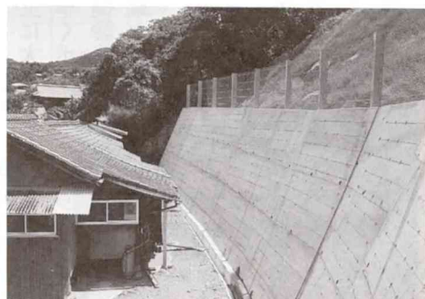
かけ崩れ防止工事がすんだばかりの皆倉地区
