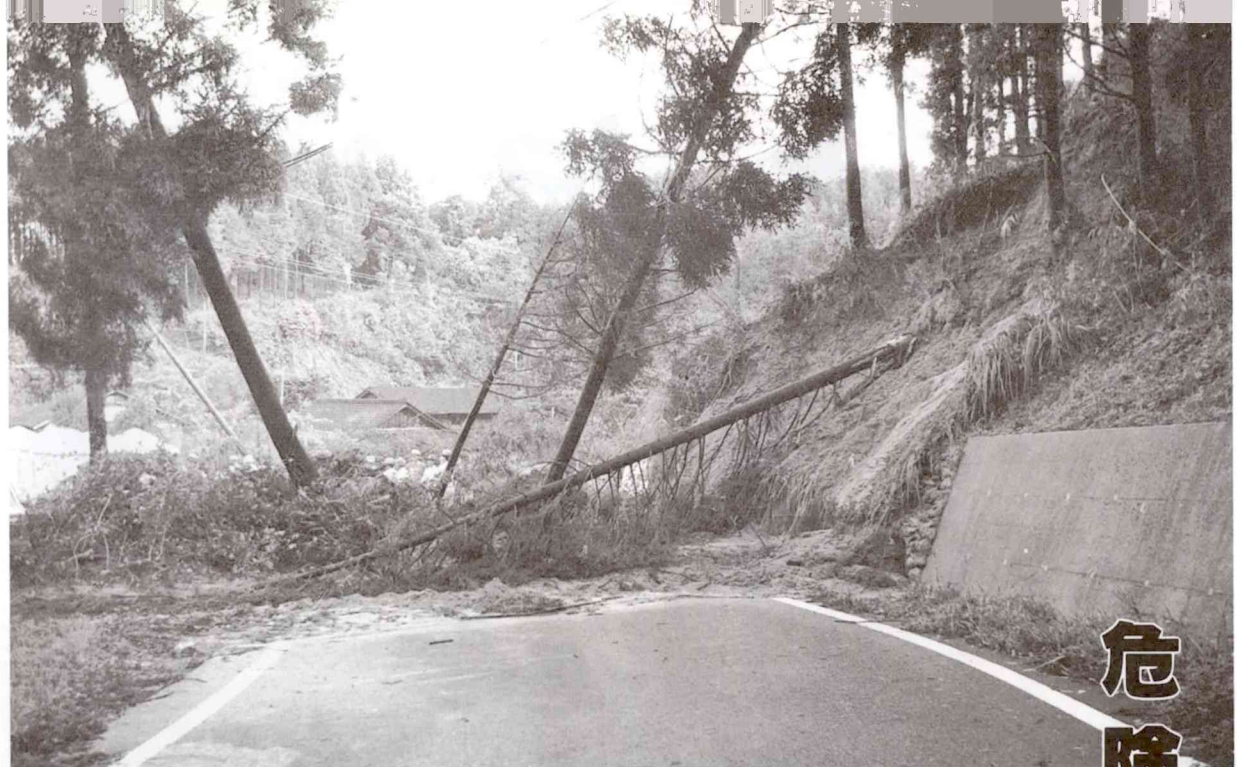
平成2年台風20号の池田川南区の土砂崩れ現場
