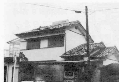
屋根の瓦やトタンが飛んだ新築家屋
