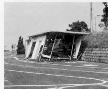
無残な運動公園の倉庫
