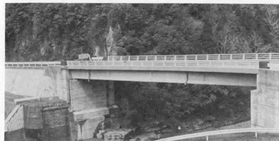
完成した厚ヶ瀬橋
