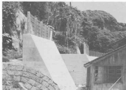
城ヶ崎擁壁工事
