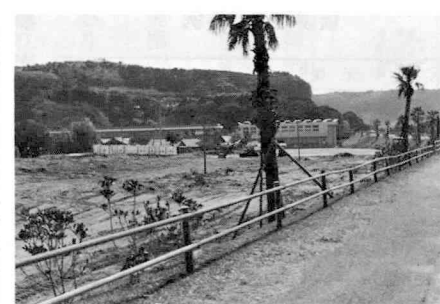
(神川地区公民館造成工事)
