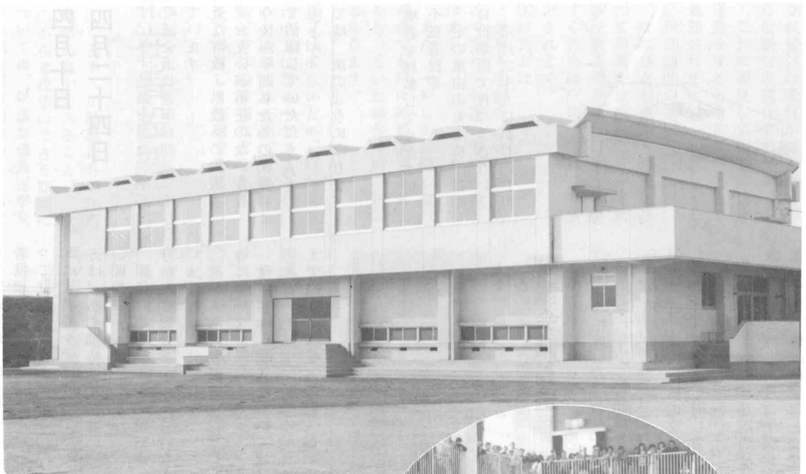
完成した神川中屋内運動場
