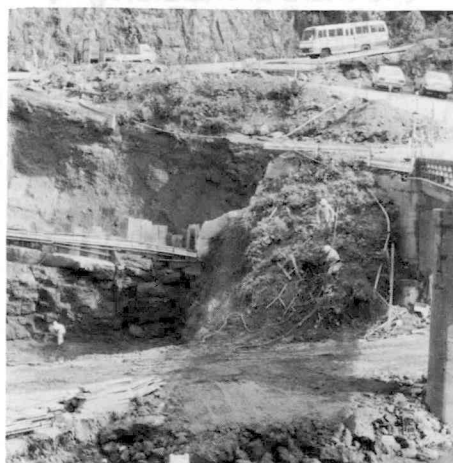
厚ヶ瀬橋の新設工事
