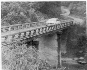
架け替えが決定した厚ヶ瀬橋
