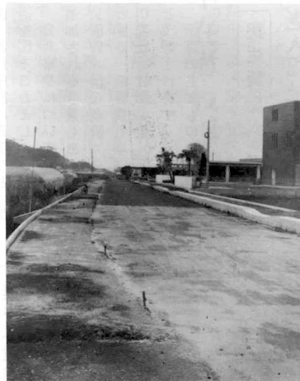
難こうした国道（バイパス）の用地交渉も完了し工事に着工したばかり
