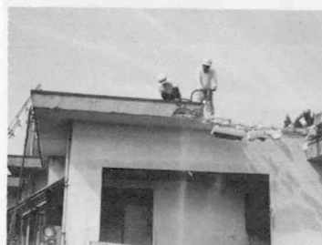
工事が始まった老人ホーム
