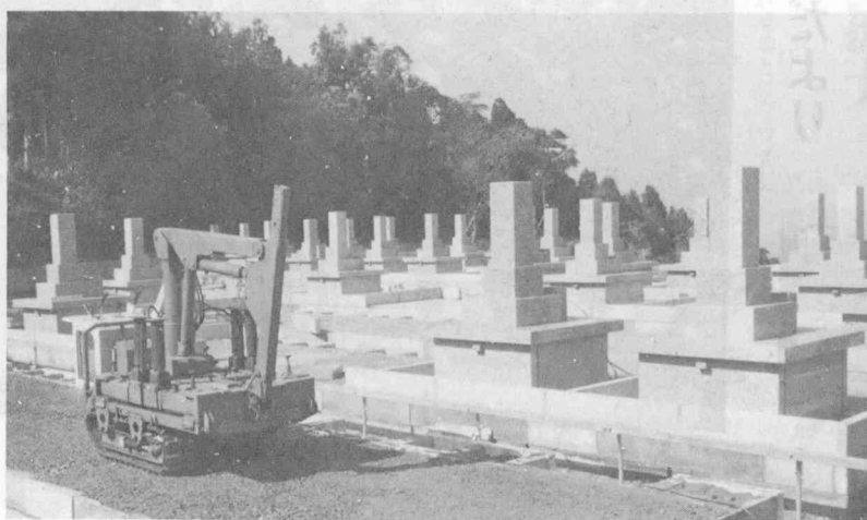
整然と配置された納骨堂
