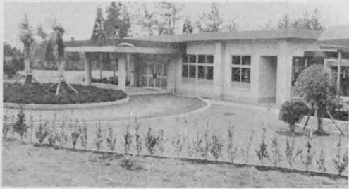
鹿屋市下高隈町に完成した 共同火葬場
