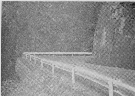
(完成した農道神川線)
