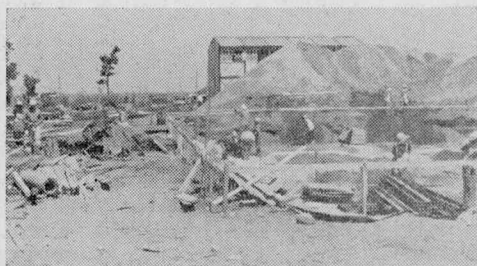
(工事中の大根占電報電話局)
